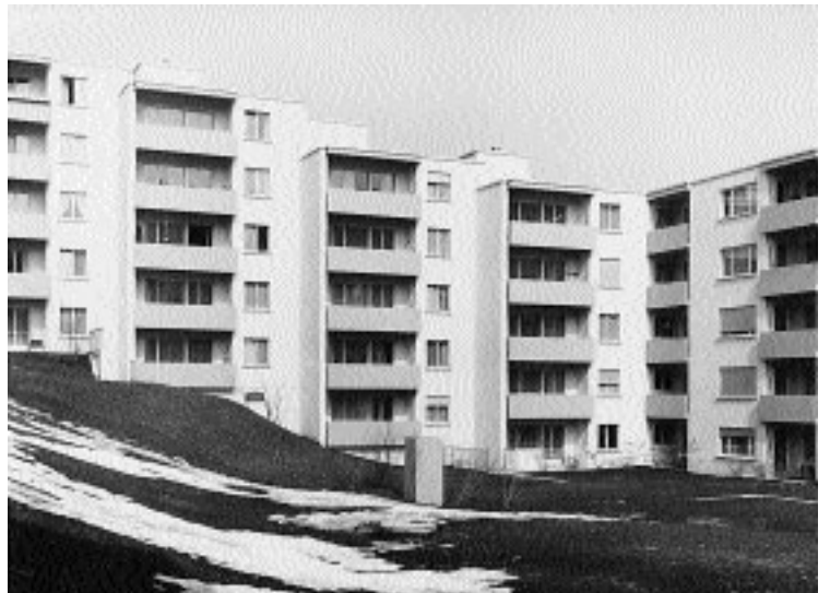
Die Siedlung Rappenhalde in Effretikon wurde von einer Generalunternehmung konzipiert und erstellt. Die Genossenschaften ASIG, ABZ und Röntgenhof aus Zürich traten als Investoren auf; sie kauften 1965 das baureife Projekt mit 433 Wohnungen im unspektakulären Stil der Hochkonjunkturzeit. (Architektur: Karl Steiner AG)
