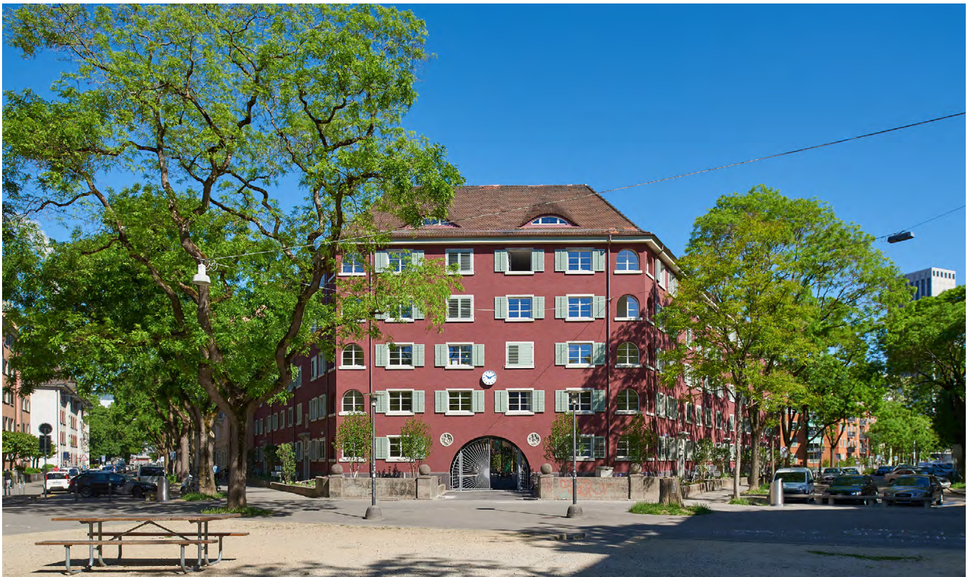
Industrie 2 «Roter Block» der BEP, 2015-2017: Gesamterneuerung der 100-jährigen Siedlung in Zusammenarbeit mit der städtischen Denkmalpflege (Foto: BEP)
