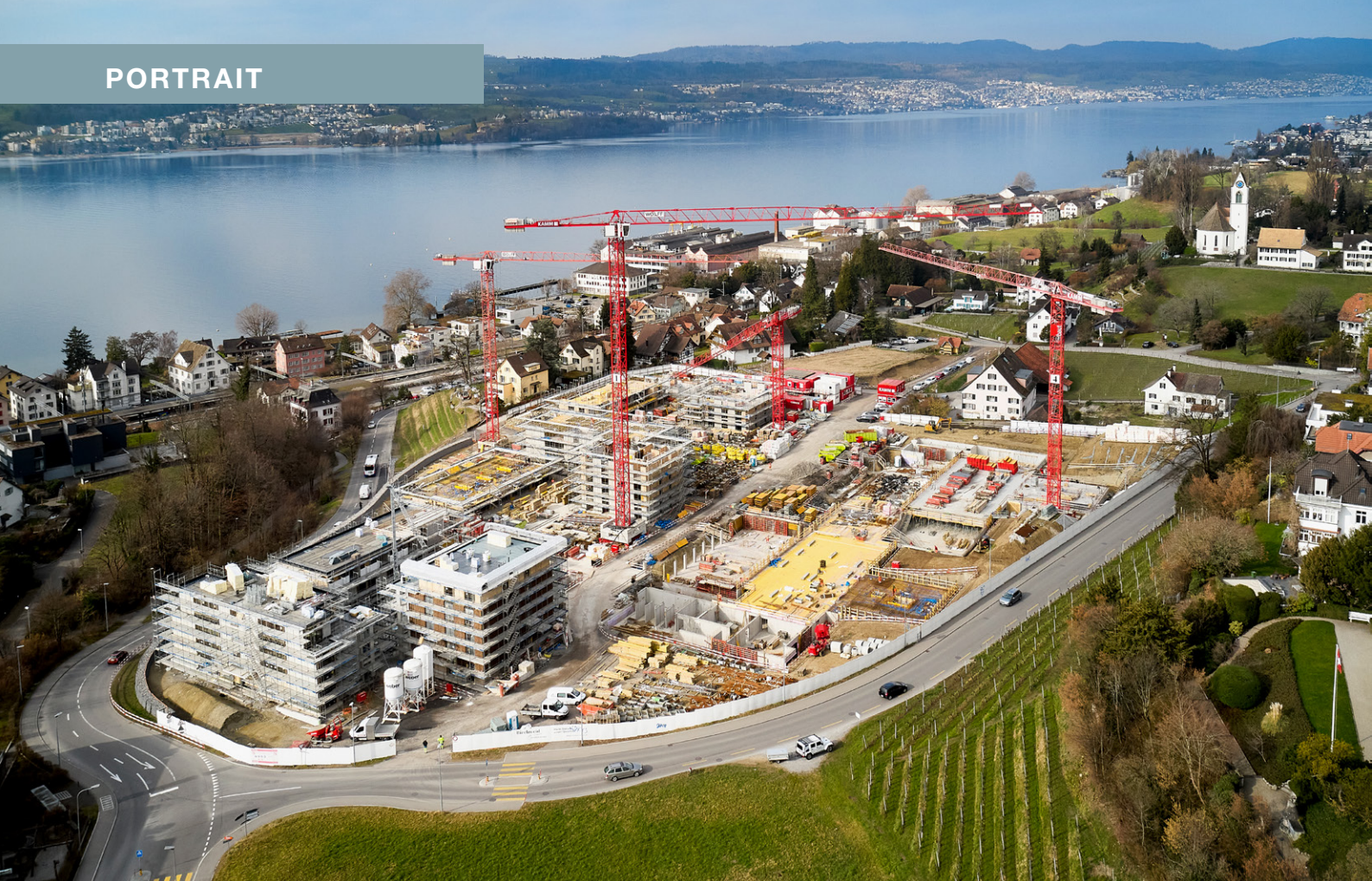
Erstbezug in zwei Etappen: der Neubau Birchweid mit 44 Genossenschaftswohnungen in Uetikon am See. (Foto: Yves Roth)
