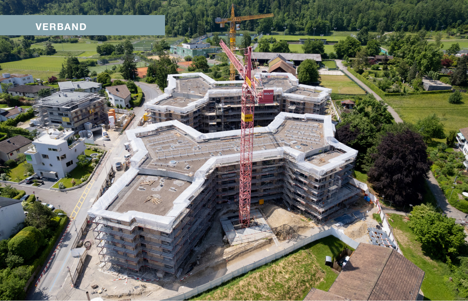
Der Ersatzneubau Zwischenbächen der Baugenossenschaft für neuzeitliches Wohnen in Zürich Altstetten. (Foto: Igor Balta)
