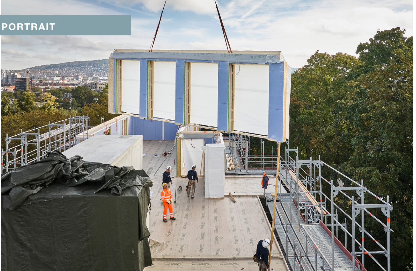
Ersatzneubau Triemli 4 in Zürich: Das oberste Stockwerk wird aufgerichtet. (Foto: Nakarin Saisorn)
