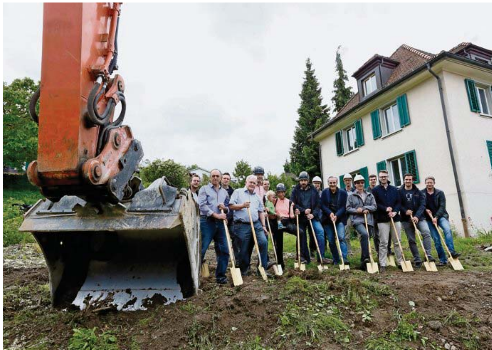
Die erste Erde ist ausgehoben: Ab Herbst 2018 sollen 81 Wohnungen bezugsbereit sein.
