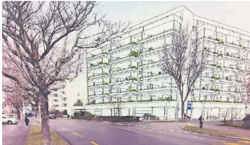
Bis zu 48 Wohnungen wird das Schächli-Objekt in der Asylstrasse umfassen. ZVG
