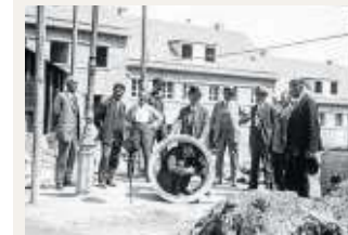
Baustellenbesichtigung des Vorstands in der Siedlung Entlisberg II (1929).
