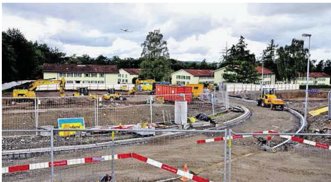
An Südlage oberhalb der Flughafenwerft lebt es sich in der Wohnbaugenossenschaft Holberg sehr stadtnah, aber dennoch wie im Grünen. Allerdings übertönen die Baumaschinen derzeit sogar die Flugzeuge. Christian Wüthrich
