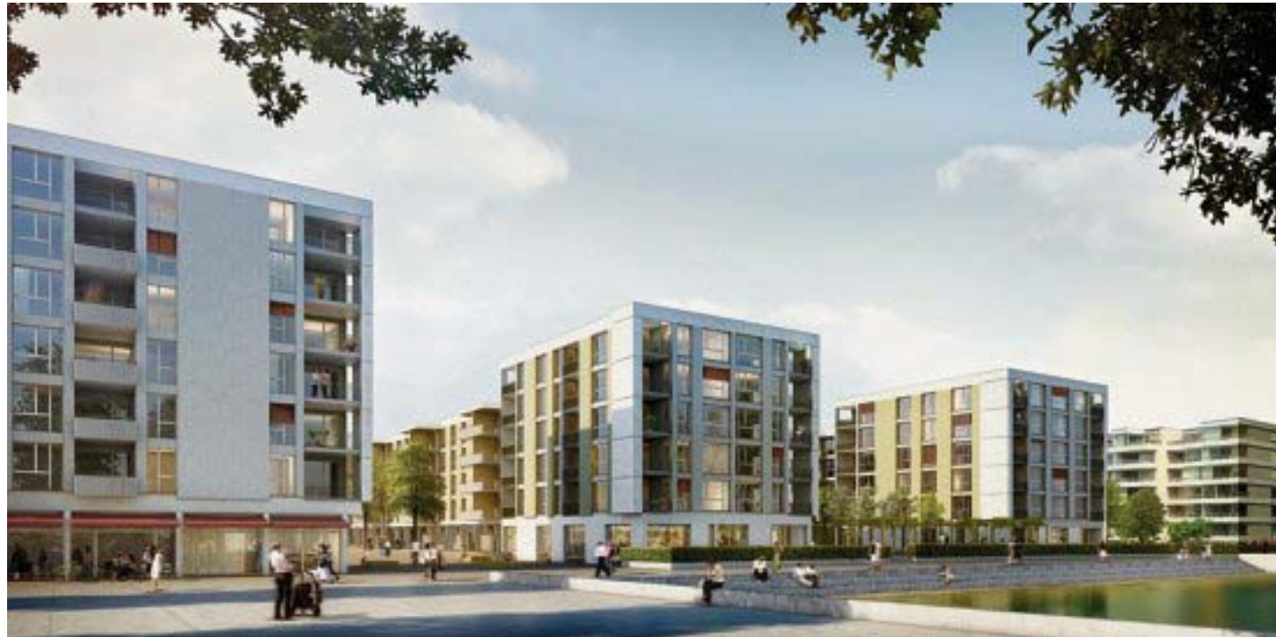
Gleich neben dem Glattparksee soll bis im Herbst 2018 die Genossenschaftssiedlung entstehen.
