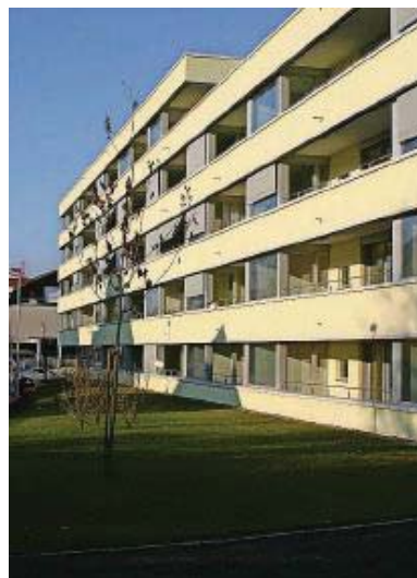
Im Mietpreis der Alterswohnungen an der Bachstrasse ist ein Zusatzangebot inbegriffen. ARU
