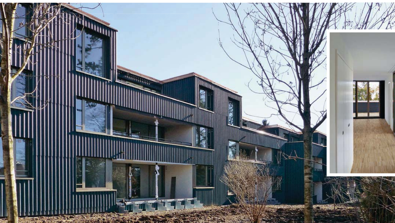
Die Fassade aus Welleternit prägt das Mehrfamilienhaus im Garten des Schwesternhauses Dollikon.
