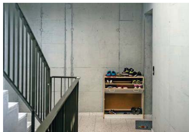
Die Treppenhäuser sind noch grau - die Feuerpolizei will es so. Fotos: Reto Oeschger
