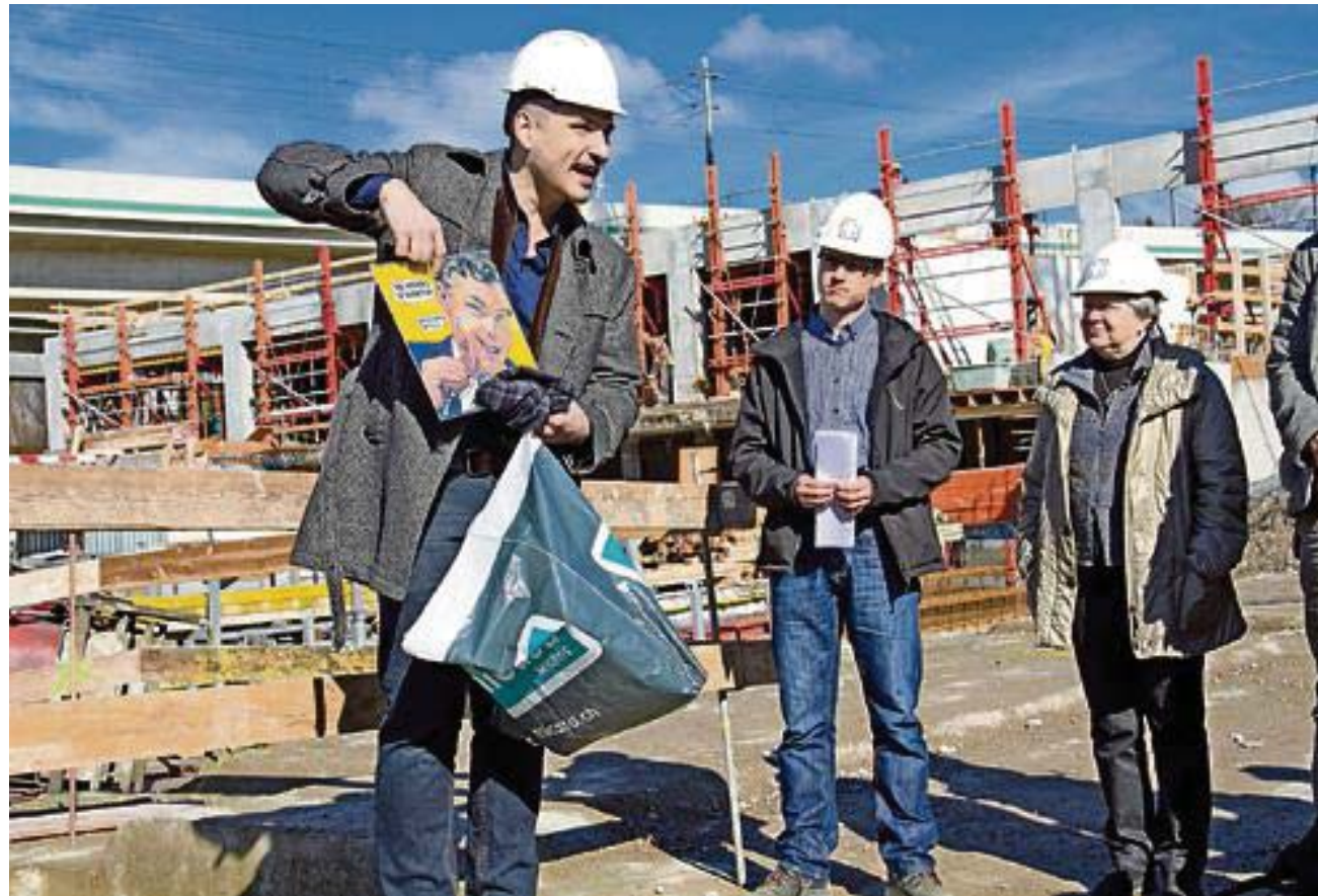
Ivo Hasler (links) trennt sich von einer seltenen Schallplatte, die kurz danach in der Baustelle des Kraftwerks 1 einbetoniert wurde – in der Nähe des Lifts, auch wenn es sich nicht um Liftmusik handelt, sondern um Frank Zappa. Bild: Michel Sommer
