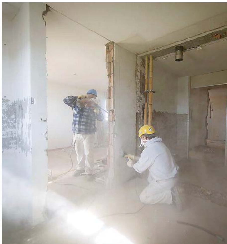
Baustelle: Für die neuen 3-Zimmer-Alterswohnungen müssen Wände herausgebrochen werden.
