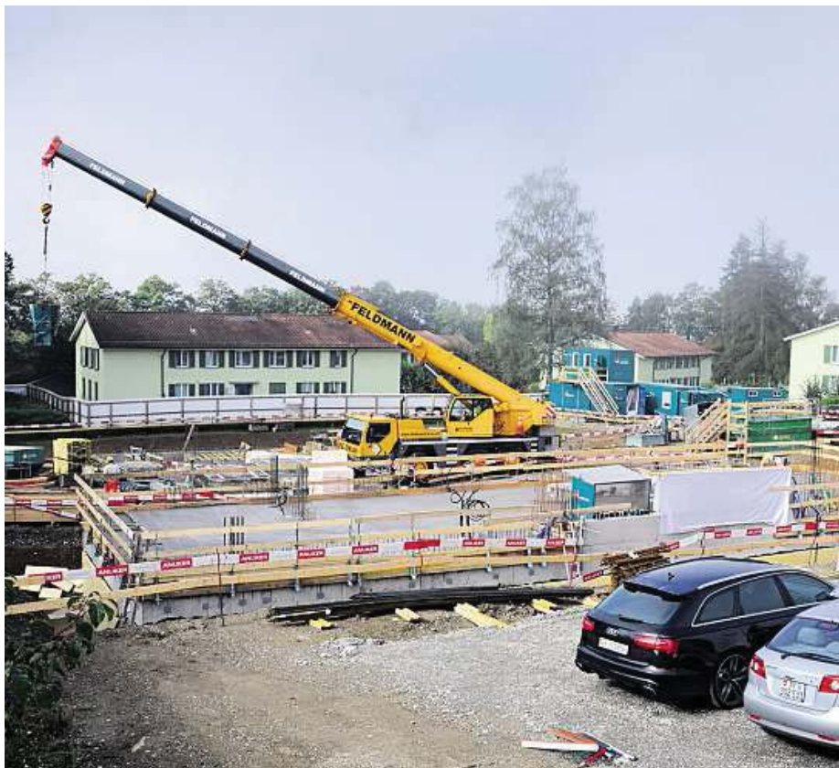
Nur mit einem einzigen mobilen Pneukran kann auf der Baustelle am Holberg momentan gearbeitet werden. Die Bauherrschaft bräuchte aber mindestens drei Kräne, sonst drohen grosse Verzögerungen und Mehrkosten. cwü
