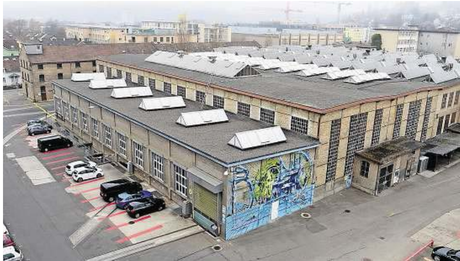
Blick auf das Werk 1. Links befindet sich das Baufeld, auf dem die Genossenschaftswohnungen entstehen. mad
