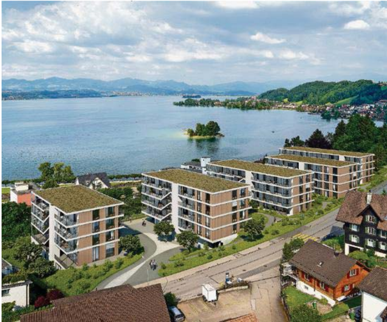
An der Schwyzerstrasse sollen unter dem Namen Wohnen Plus fünf viergeschossige Gebäude entstehen.
