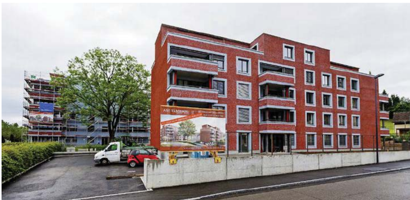
In die Neubausiedlung am Tämbrig wird auch ein Hort der Primarschule Uster einziehen. Er befindet sich im Erdgeschoss des noch eingerüsteten Hauses an der Steigstrasse 9.
