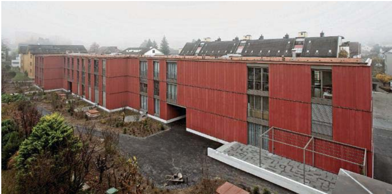
An der Tiefackerstrasse ist eine Siedlung entstanden, die die neusten Vorgaben in Sachen Minergiebauweise erfüllt.
