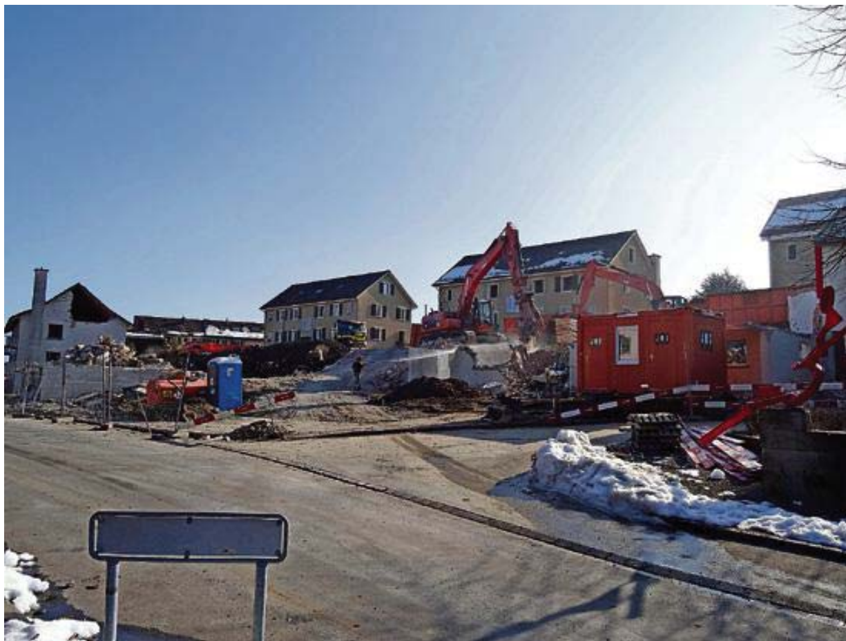
Für die Neuüberbauung müssen erst noch alte Genossenschaftshäuser abgerissen werden. Die Abbrucharbeiten starteten vor drei Wochen.
