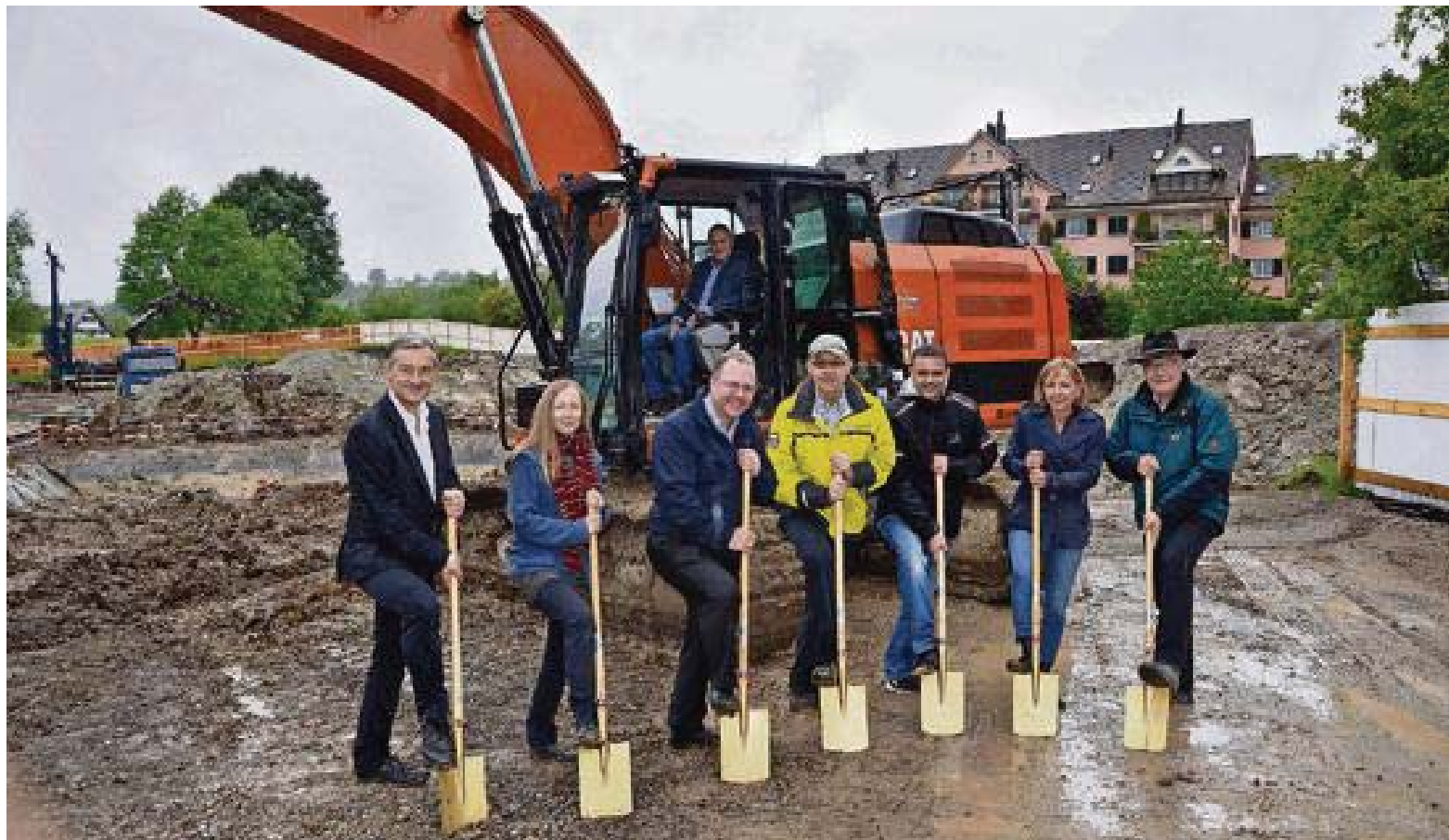
Die Verantwortlichen standen gestern beim Spatenstich für die Überbauung Scheug im Regen. «Hoffen wir, dass wir während der Bauphase mehr Glück haben als heute mit dem Wetter», sagte Walter Graf, Präsident der Baugenossenschaft Uetikon (im Bagger). Malte Aeberli
