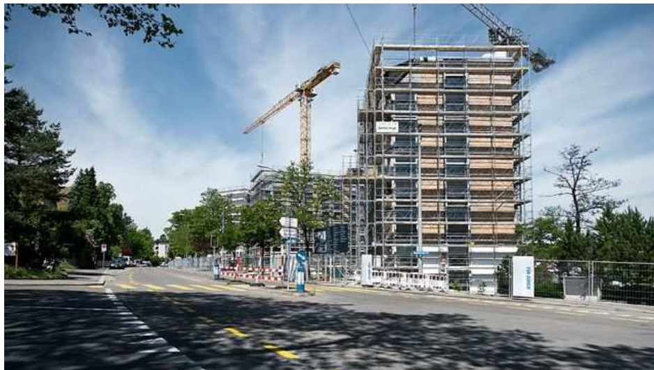
Baustellenrundgang durch die neu entstehende Wohnsiedlung an der Rautistrasse in Zürich, am 21. Mai 2014 (Bild: Adrian Baer / NZZ)
