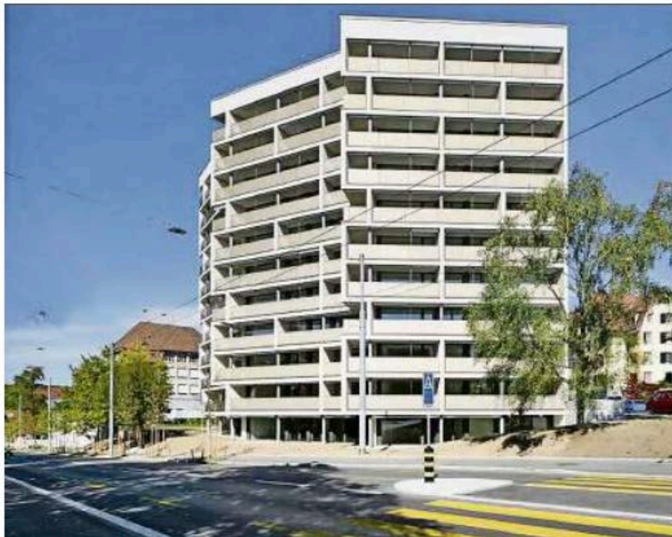
Das zehngeschossige Hochhaus ist von Weitem zu sehen.
