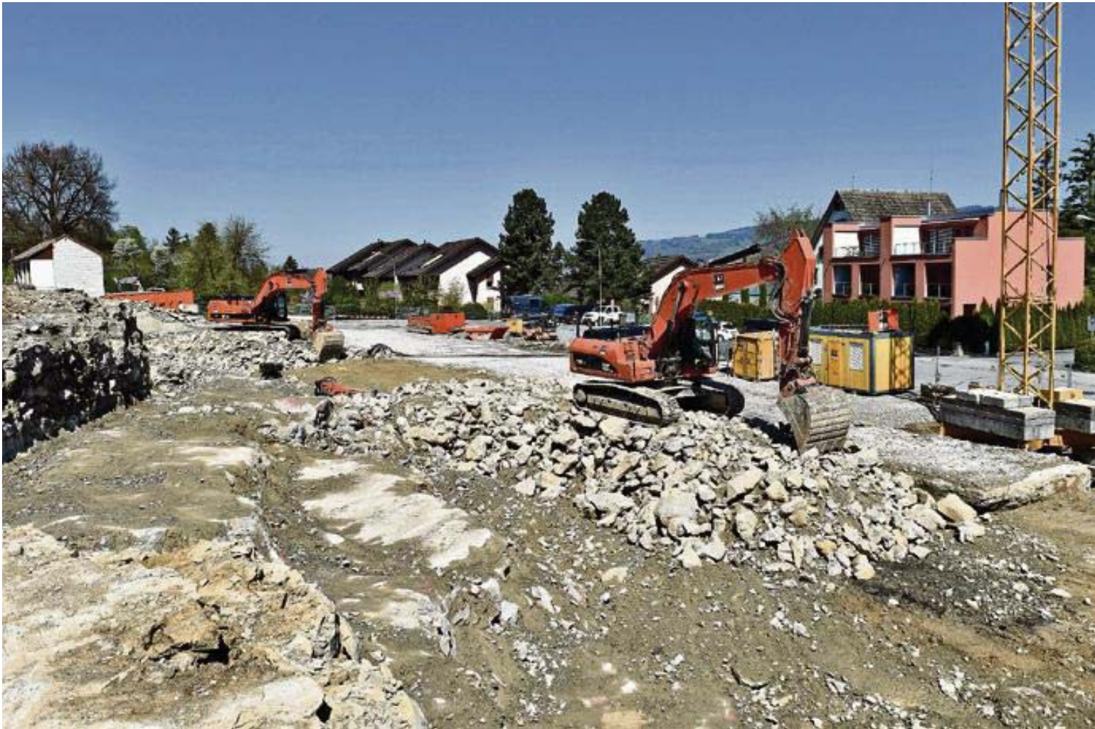
BiS Frühling 2017 entstehen mit der Grossüberbauung «Four Sisters» 50 kostengünstige Genossenschaftswohnungen.
