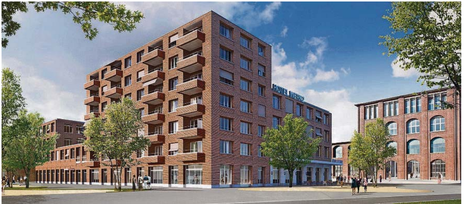
Diesen Frühling ist die Baueingabe des Projekts Hotel WerkZwei geplant. Zum Komplex gehören Wohnungen im urbanen Stil und Gewerberäume. Rechts das Hamel-Gebäude.
