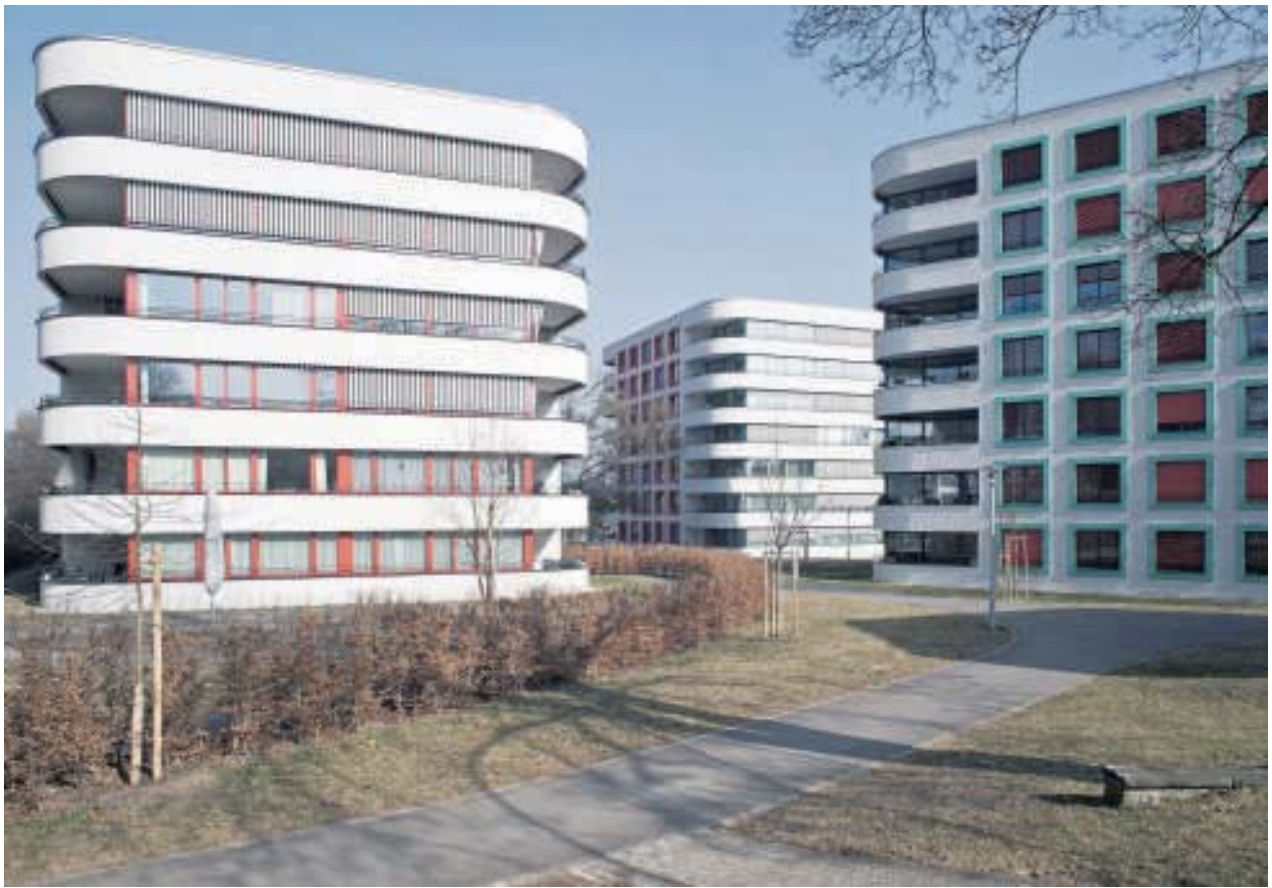
Neubauten der Baugenossenschaft Sunnige Hof in Albisrieden (Else-Züblin-Strasse).
