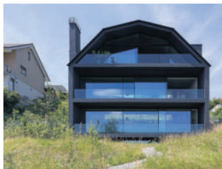
Blick auf Naturgarten, See und Berge: Neubau in Thalwil.
