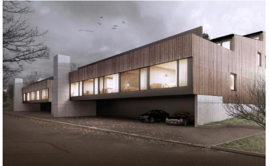
Meisenrain in Gockhausen: Kleine Wohnateliers lassen sich zu grösseren Einheiten erweitern
