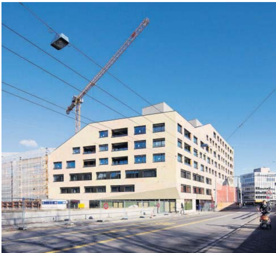
Die neueste Blockrandsiedlung im Zürcher Kreis 4 empfängt bald ihre ersten Mieter.
