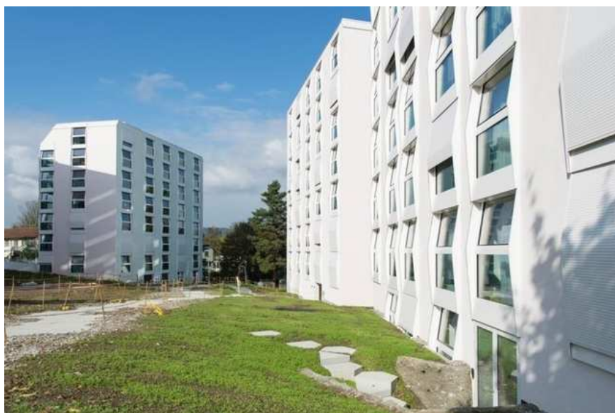
Ein Beispiel für bezahlbare Wohnungen: Wohnblöcke der städtischen Wohnsiedlung in Zürich-Altstetten. (23. Oktober 2014) Bild: Keystone
