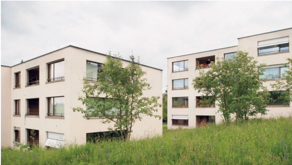
Am Hagenbuchrain hat die Baugenossenschaft Sonnengarten städtisches Land günstig im Baurecht erhalten. (Bild: Goran Basic / NZZ)
