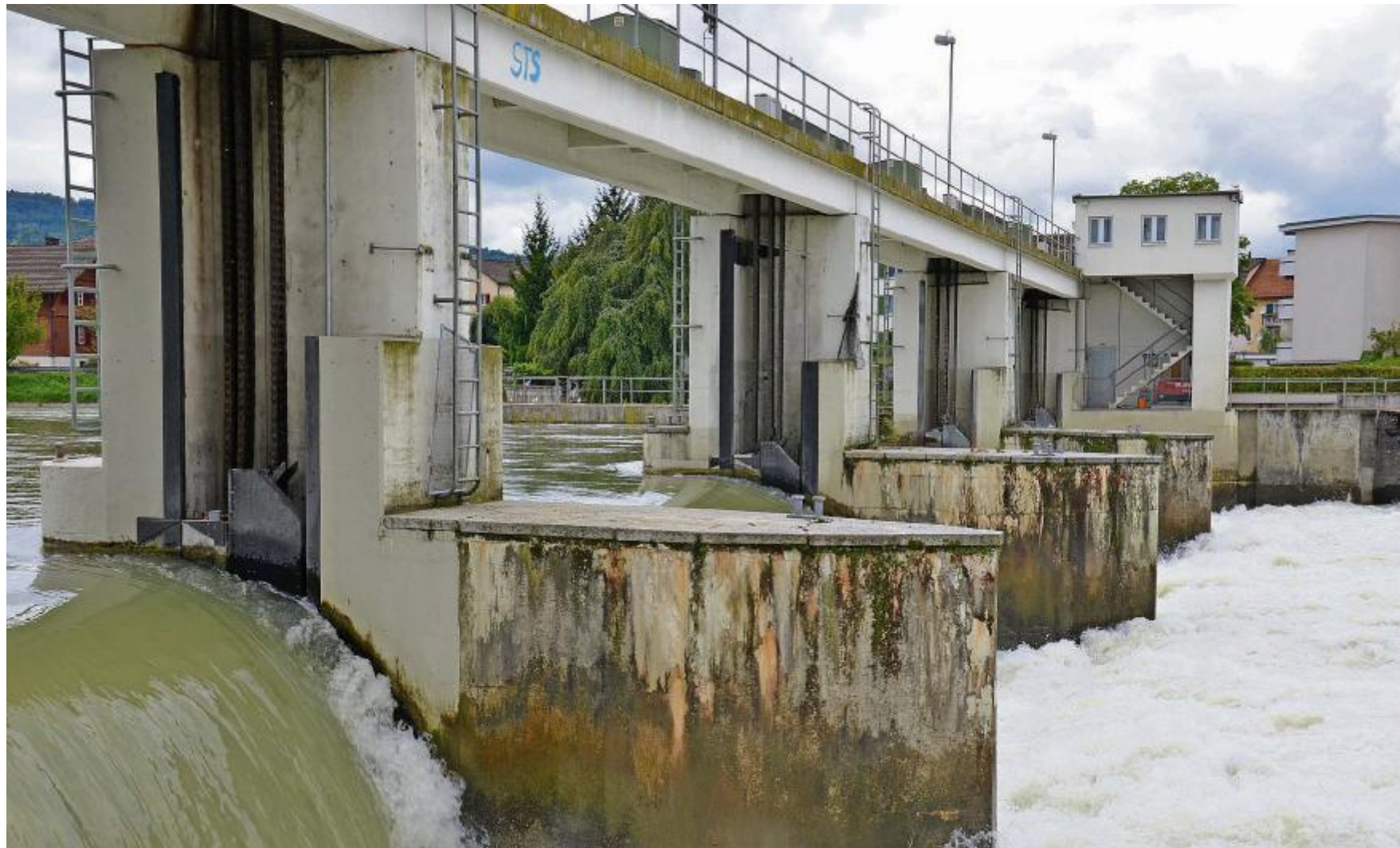
Beim Wehr wollen die EKZ ein unterirdisches Kleinkraftwerk bauen, um die Stromproduktion zu erhöhen.
