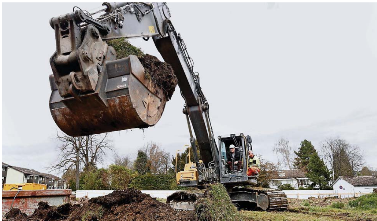
Nicht nur ein Häufchen Erde, sondern mehrere Baggerschaufeln voll hob Ruedi Schellenberg, Präsident der Baugenossenschaft Rüschtikon, beim gestrigen Spatenstich auf dem Reithalle-Areal aus.
