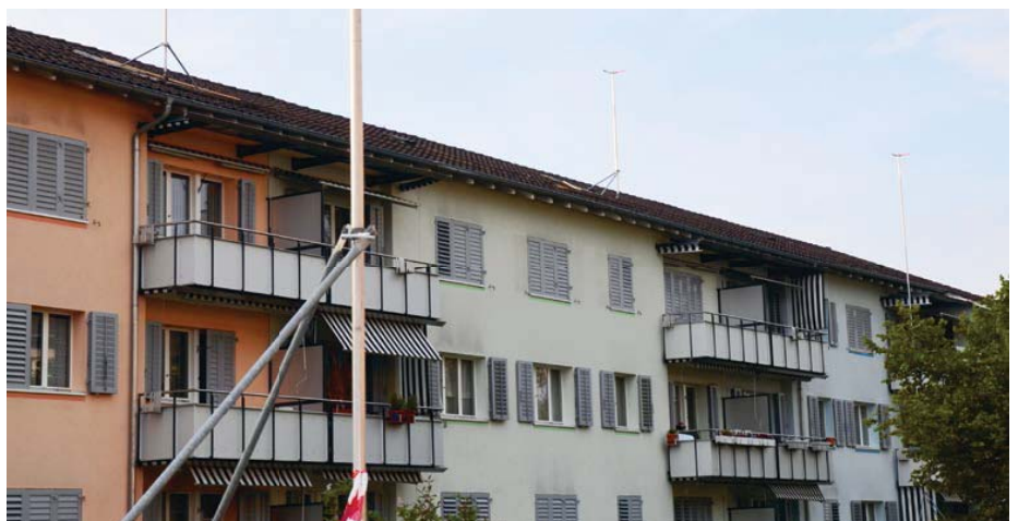
Sanieren oder Neubau? Abklärungen ergaben, dass nach einer Sanierung die Mietzinse in nicht vertretbare Höhen klettern würden.
