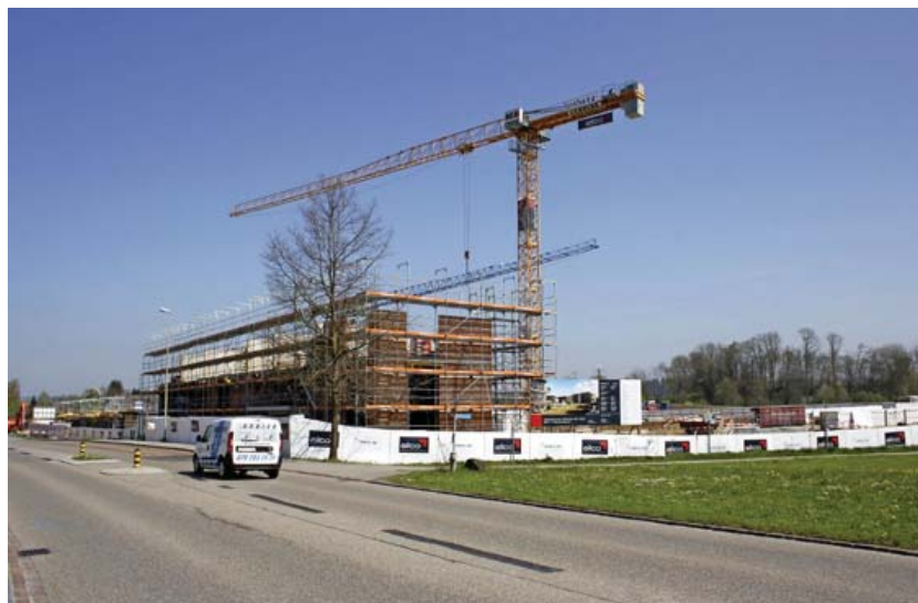
Auf einem Teil des Areals Silbergrueb sind die Bauarbeiten schon im vollen Gang.
