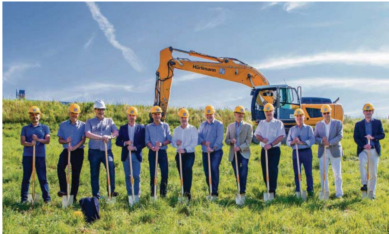
Der Bau von 71 Genossenschaftswohnungen in Kilchberg hat gestern begonnen.
