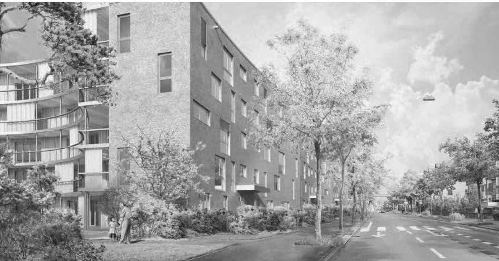
Die konkave Rückseite des Gebäudes wirkt modern.
