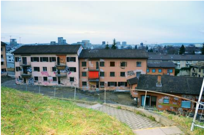
Die Gebäude werden vom Astra rückgebaut, denn hier soll ein Installationsplatz entstehen. Fotos: pm.
