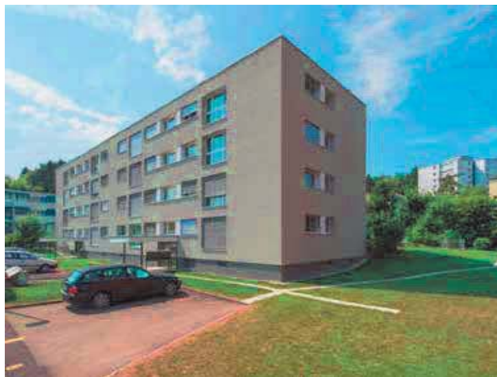
Gesamtsanierung MFH Am Brunnenbächli in Zollikerberg
