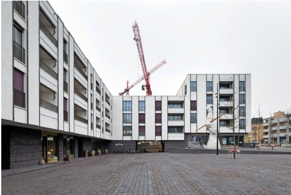
In der Stadt Zürich sind bereits heute 27 Prozent aller Wohnungen gemeinnützig: Neubau der Familienheim-Genossenschaft Zürich am Friesenberg. Foto: Gaëtan Bally (Keystone)
