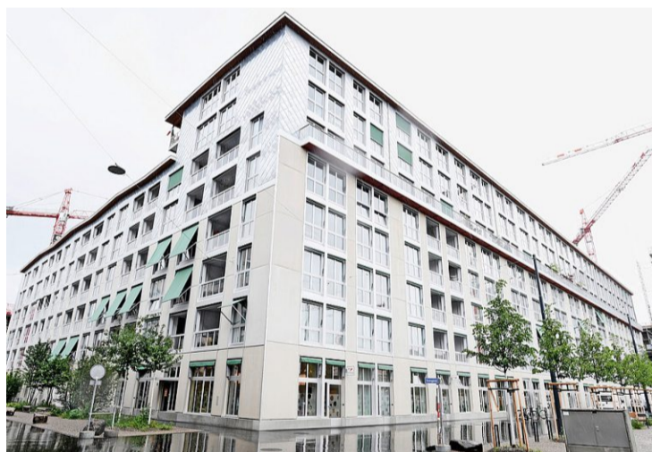
Das «Krokodil» gehört zu den grössten Holzbauten der Schweiz.
