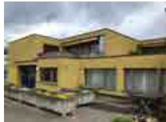
ReUse on site, Pflanztröge als Einfassung
