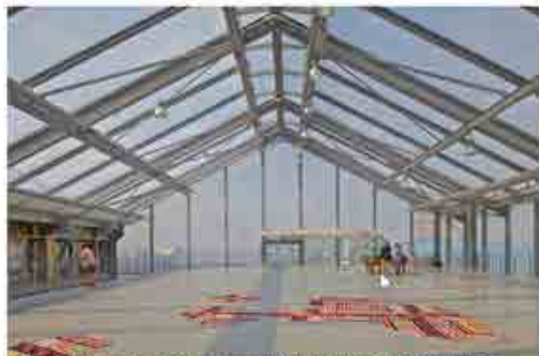
Viel Licht und Wärme dank Konstruktionen aus der Landwirtschaft: Das Zentrum für zeitgenössische Kunst (Frac) im nordfranzösischen Dunkerque (2013). Foto: Philippe Ruault
