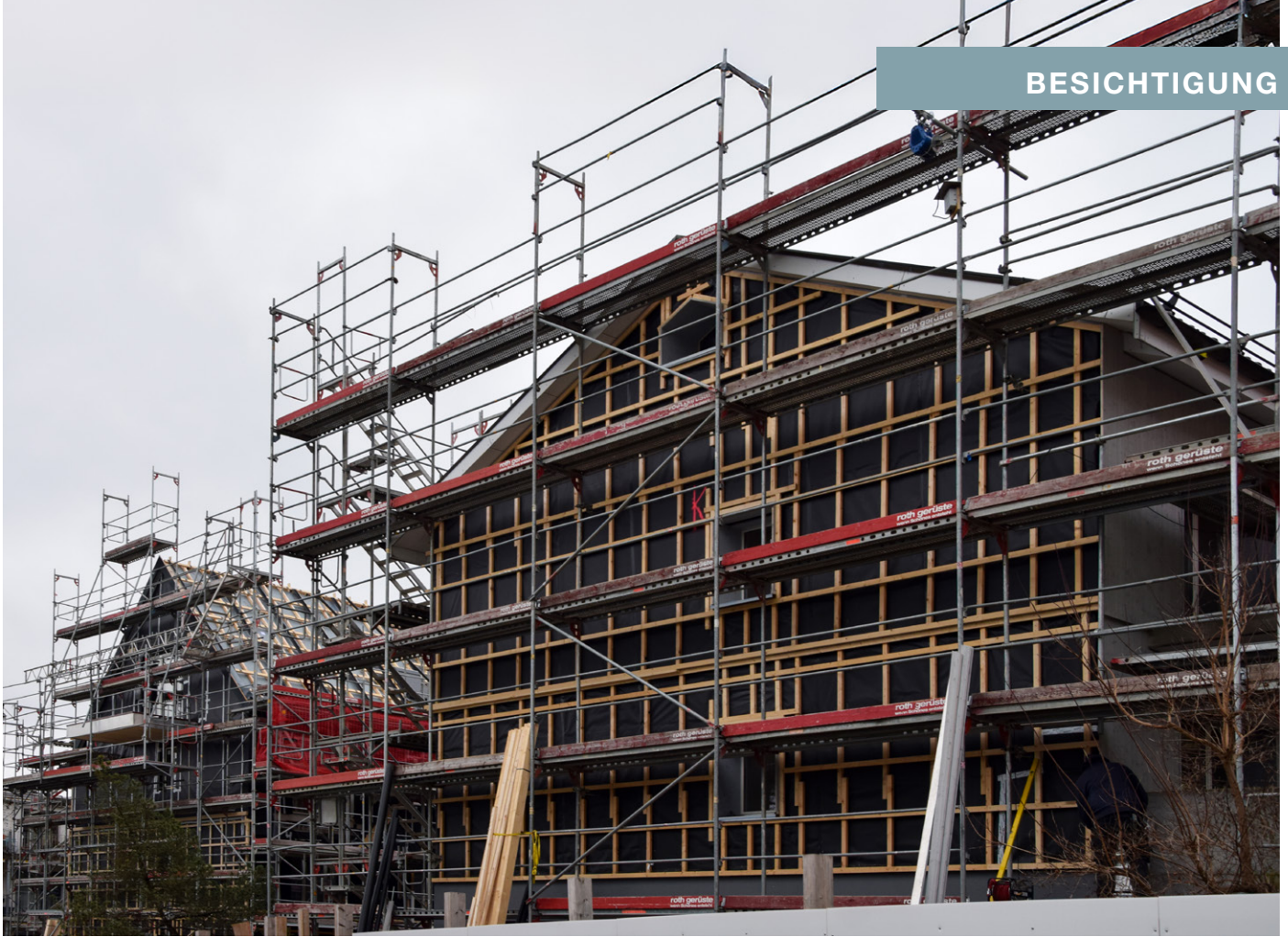
Sanierung und Aufstockung an der Bockhornstrasse – der Bezug ist auf April geplant.
