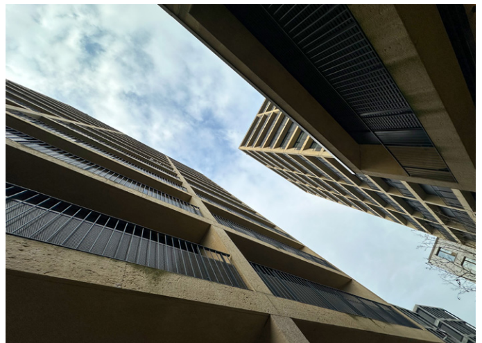
Mal gelingt Verdichtung, mal weniger.
