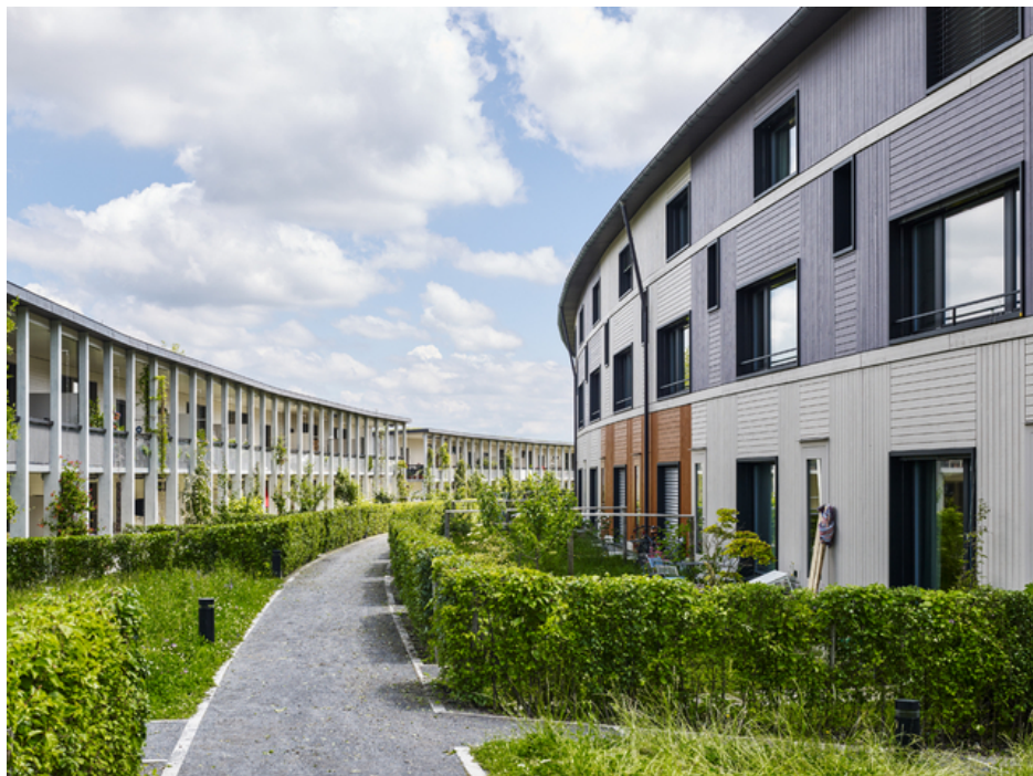
Ausgezeichnet, aber nicht vor Baumängeln gefeit: Die Siedlung Grünmatt der Familienheim-Genossenschaft Zürich (FGZ)
